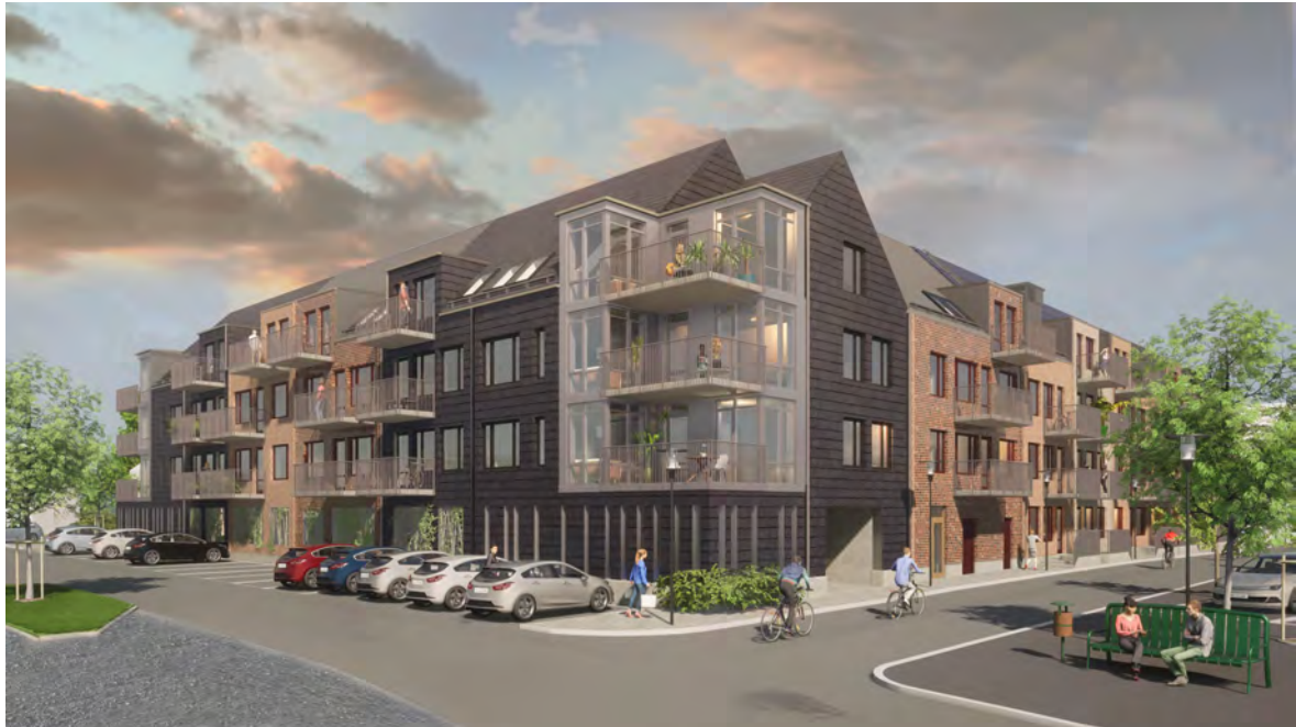
Byggnaden från sydväst i dagsljus
